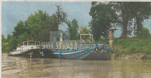
L'installation du ponton.
