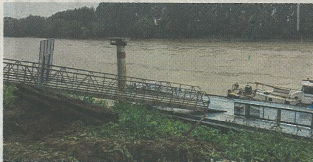
Le ponton et sa passerelle.
